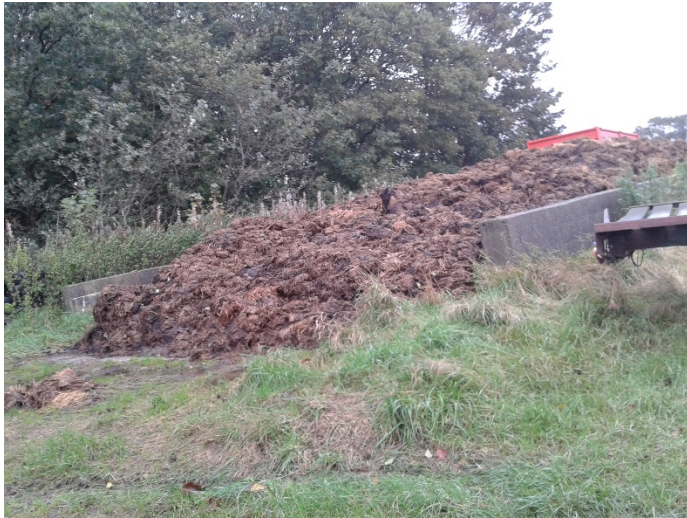
Billede taget den 8. oktober 2015, der viser at gødning på møddingspladsen ikke er overdækket og kravet om 2 meter randbelægning uden gødning ikke er overholdt.
