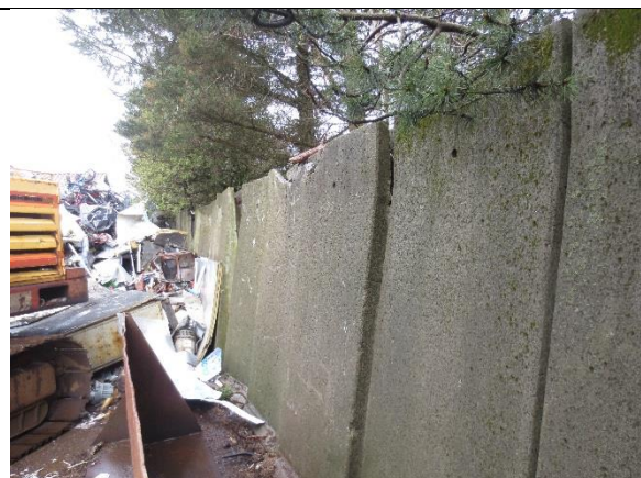
Betonelementer mellem Taksvej 5 og Vesterbro Produkthandel (set fra Granvænget 16)
